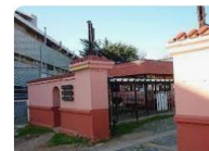
Epicentro Chile Funcionarios del Hospital Psiquiátri...
